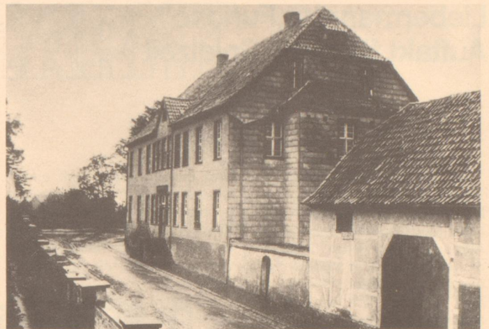
So sah es einmal an der Widumstraße aus, wo jetzt die Mietwohnhäuser und das Bürogebäude der HgB stehen.
