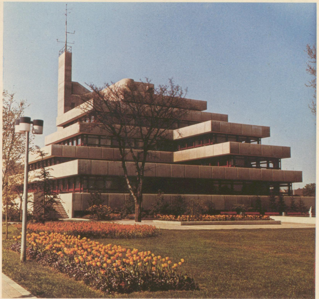
BOCKUM-HÖVEL – Neubau des Verwaltungsgebäudes
