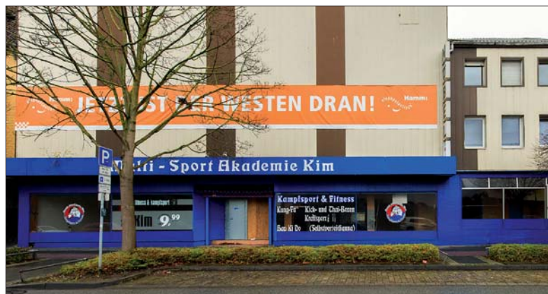
An der Wilhelmstraße 20 bis 23, wo zuletzt die Sportschule Kim zu finden war, entsteht der Neubau des Stadtteilzentrums.
